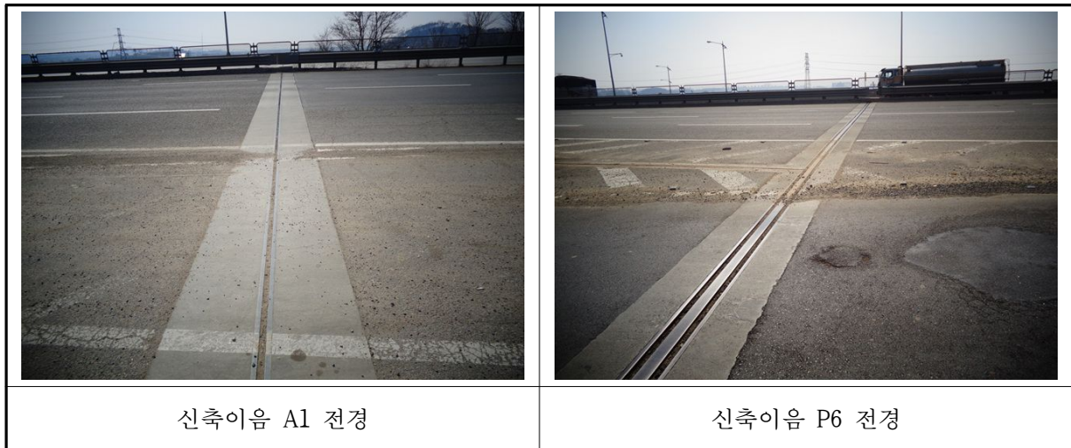
〈사진 3.8〉 신축이음 전경
