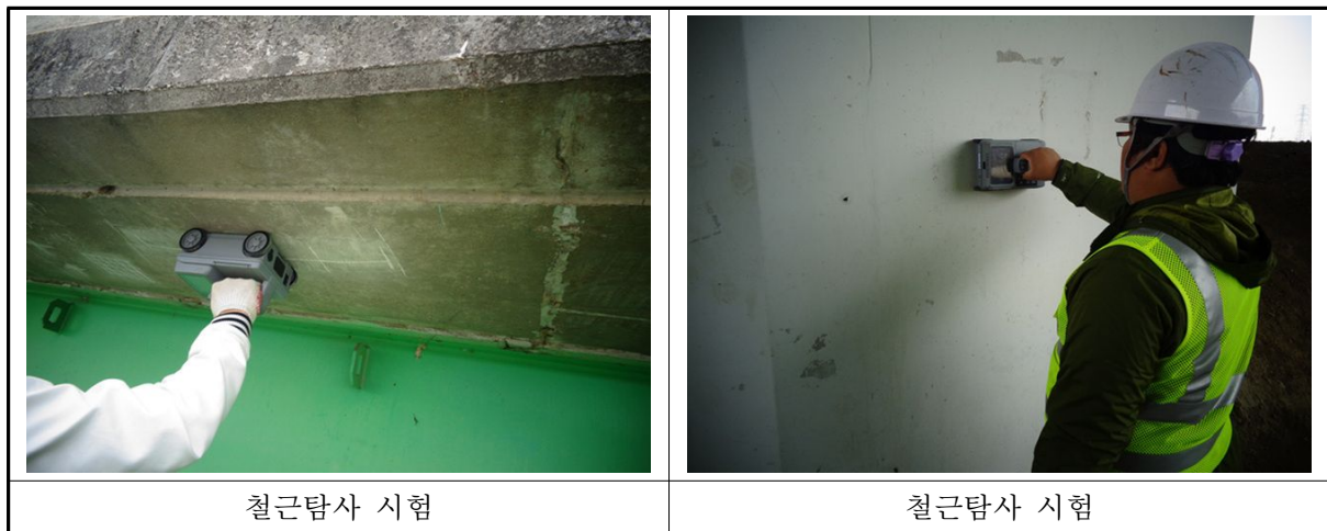
<사진 3.23> 철근탐사 현황
