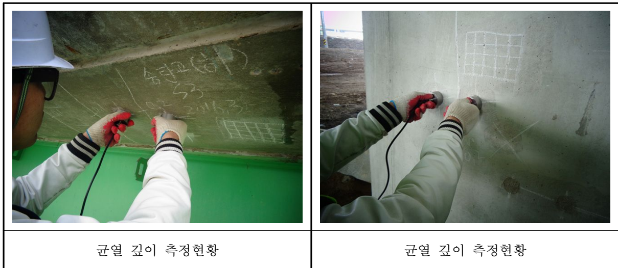
〈사진 3.26〉 균열 깊이 측정현황
