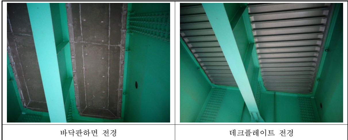
〈사진 3.11〉 바닥판하면 전경
