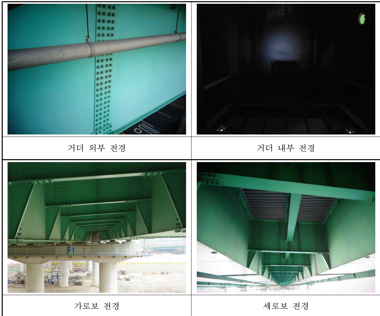
〈사진 3.13〉 거더 및 가로보 전경
