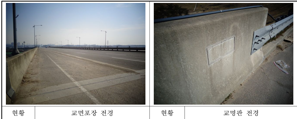
〈사진 3.2〉 교면포장 전경
